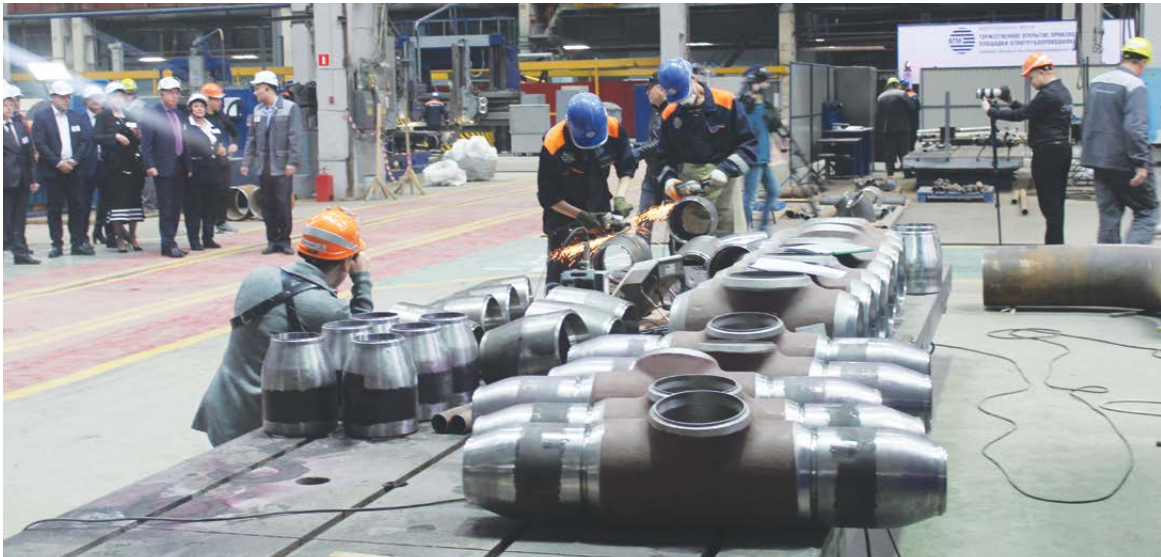
В середине декабря полку городских предприятий прибыло. Дочерняя компания АО «Атомэнергомаш» (Машиностроительный дивизион Росатома) АО «Атомтрубопроводмонтаж» (АТМ) запустила в работу производственную площадку по изготовлению трубопроводов высокого и низкого давления из углеродистых и легированных сталей.
